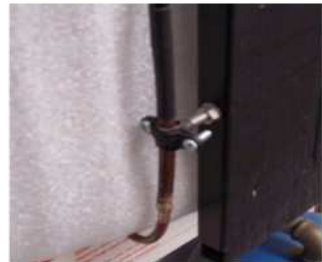
Kép a panel csöveinek alátámasztásáról
